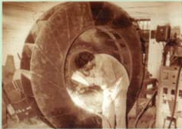
▲ Centrifugal Fan Impeller Mfg.
